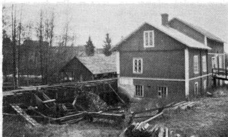
Kvarn, såg och spånhyvel vid Rexed strax före rivningen.
