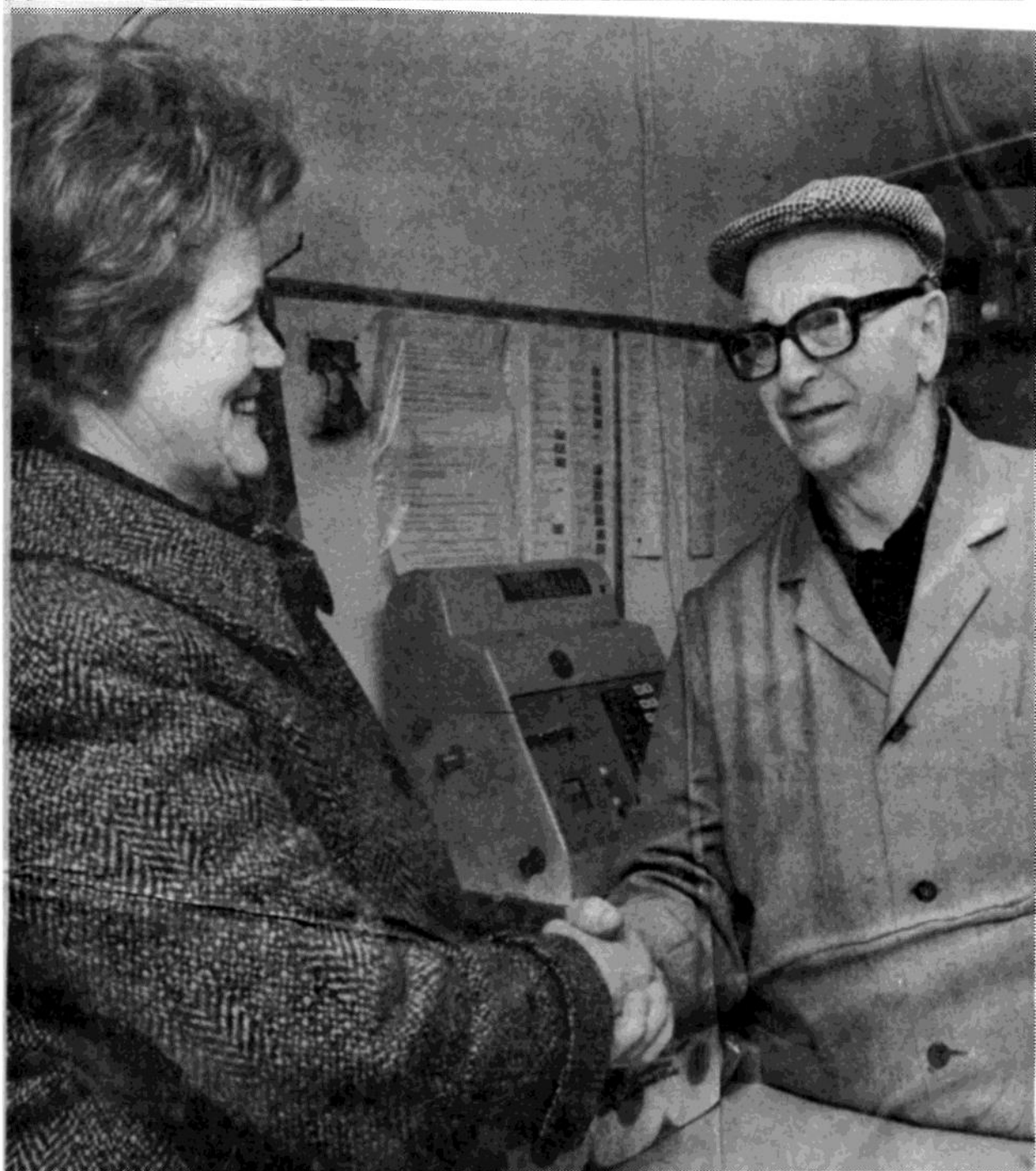
Fru Annemor Bäcklin tar farväl av Konsumbussens chaufför Stig Söderlund.
