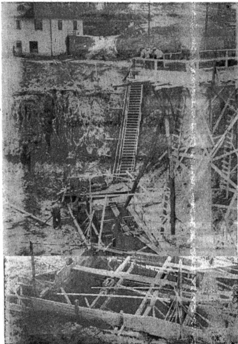
Det djupa schaktet.
