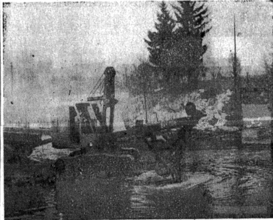
Grävmaskinen attackerar älvbotten.
