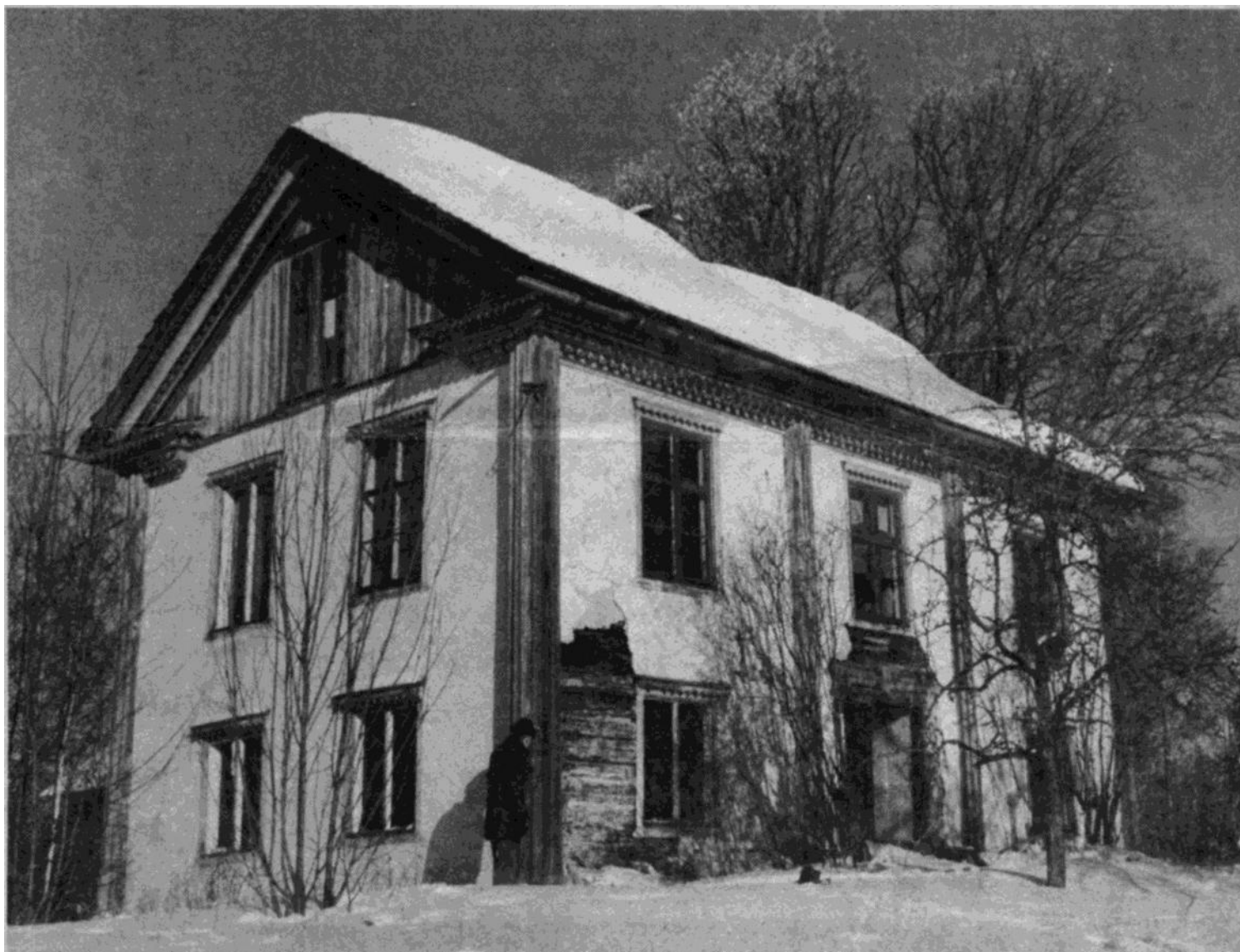
Hill tar sig en titt på virket, som man har knackat fram ur putsen över 1700-talsväggarna.
